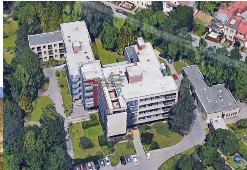
Dosluhující a nevyhovující DZR v Nopově ulici v Brně
